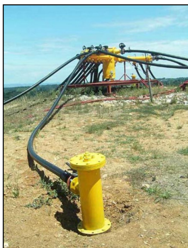
Figura 4: testa pozzo e rete di adduzione del biogas
